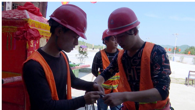
图为：施工人员在敷设广电光缆
