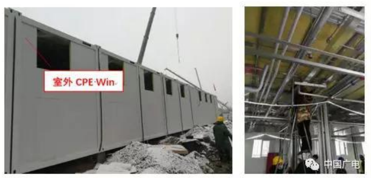
图为：小汤山医院室外 CPE win 及室内 AP 安装勘测现场
