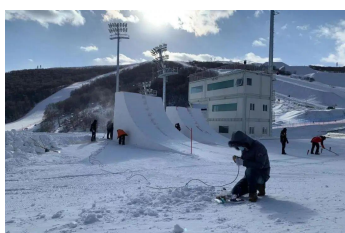
▲设备现场调试
