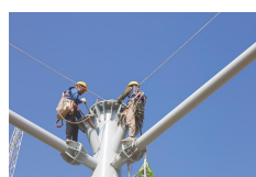
图为：海南发射场 2 号发射位正紧锣密鼓地建设中
